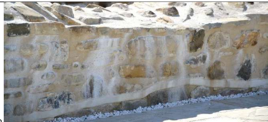
Figura 6. Beciurile de pe latura de sud (a) și ruine din incintă (b) – umiditate ascensională/infiltrații (a) și eflorescențe saline (b).
