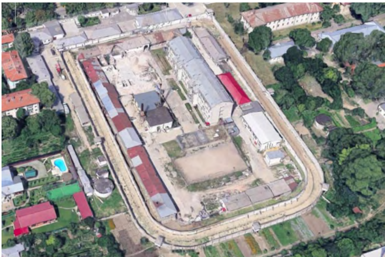
Fig. 10. Închisoarea Galați - vedere din Google Earth, 2024.
