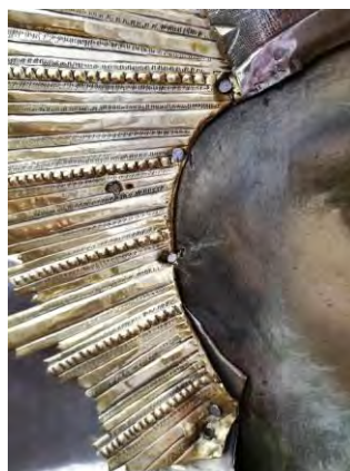
Foto 15 : cuiile ferecăturii sunt de diferite tipuri majoritatea nepotrivite pentru astfel de prinderi
